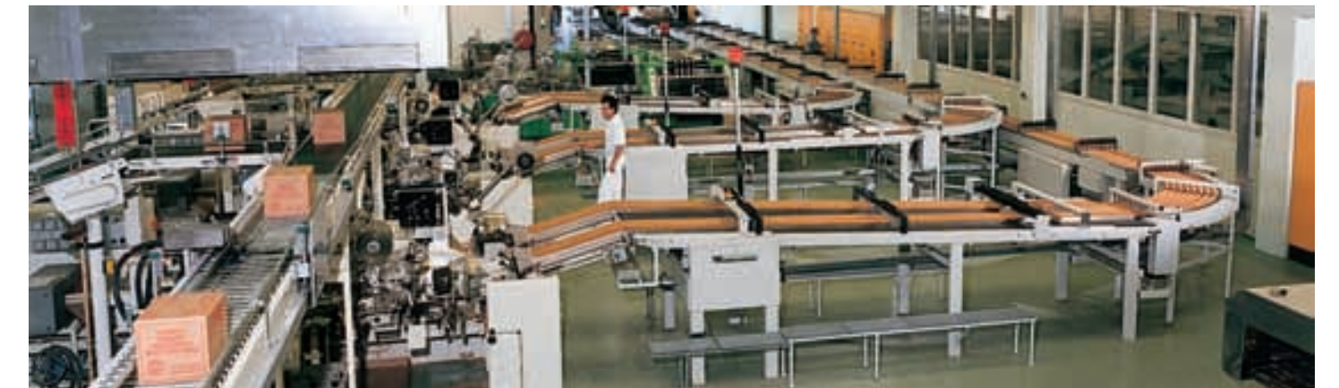
7 Convoyeur de refroidissement avec alimentation automatique vers les machines d'emballage.
